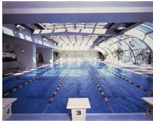
【5階 ザ・クラブ室内プール】
